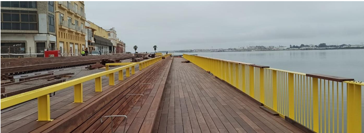
Proyecto "Ayamonte Mira el Río" | Fuente: https://canalcostatv.es/el-proyecto-ayamonte-mira-al-rio-al-85-por-ciento-de-ejecucion/
