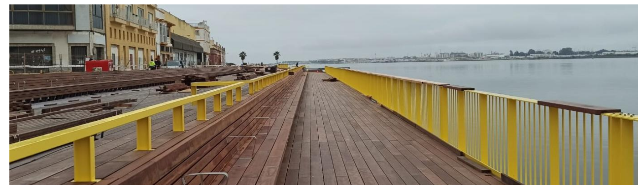
Proyecto "Ayamonte Mira el Río" | Fuente: https://canalcostatv.es/el-proyecto-ayamonte-mira-al-río-al-85-por-ciento-de-ejecucion/
